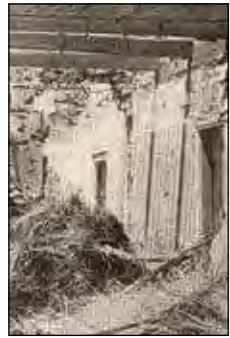
Die binnekant van die huis met sloping Foto: TE Andrews
